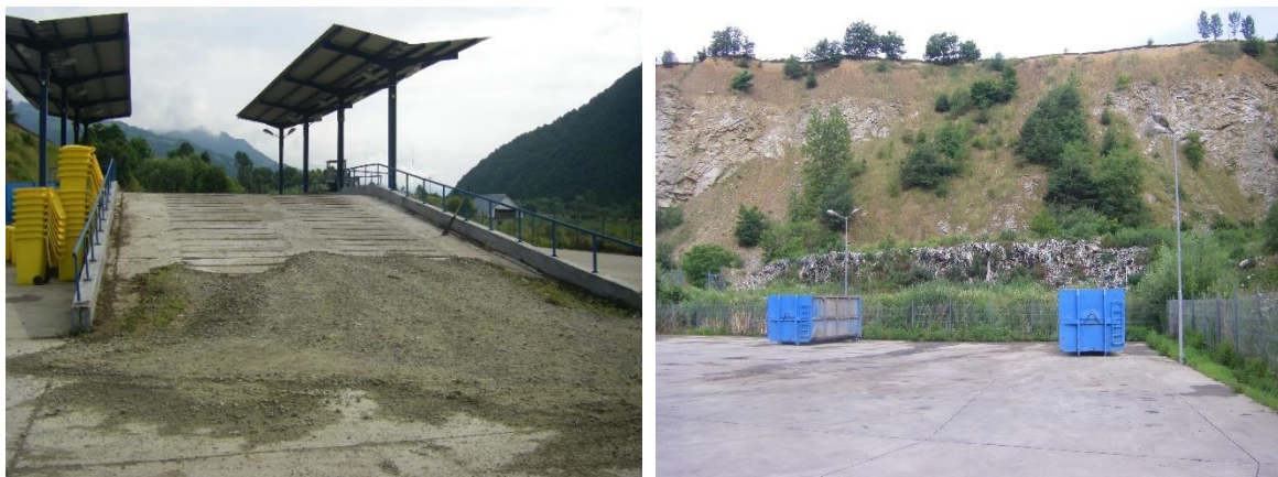
Figura 2-17 – Stația de transfer și Centrul de colectare Sângeorz-Băi
